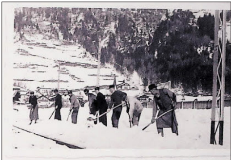
Gleisarbeiter bei der Schneerräumung.
