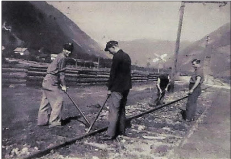
Arbeiter an der Bahnstrecke.
